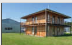
Holzhaus mit Lagerhalle/Werkstatt & Kaiserstuhlblick! ID W-01FTA, KP € 495.000,-
